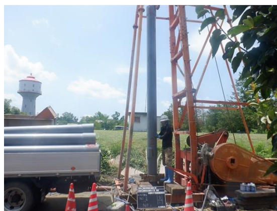
＜消雪井戸・さく井工事の様子＞
