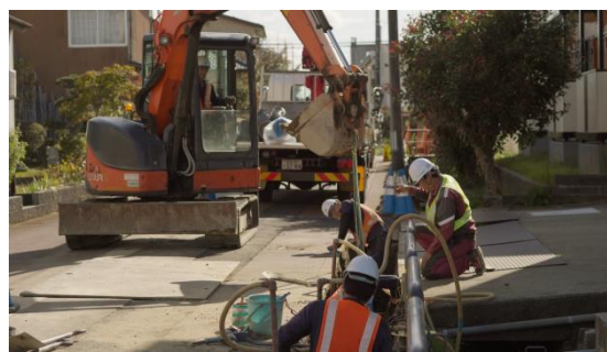
＜管工事現場の作業風景＞
