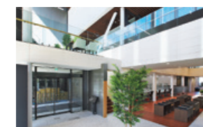
2018年10月に完成した新本店は、自然通風を活かした空調設備を設置
